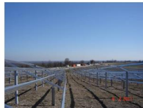
Fixation des rails de support
