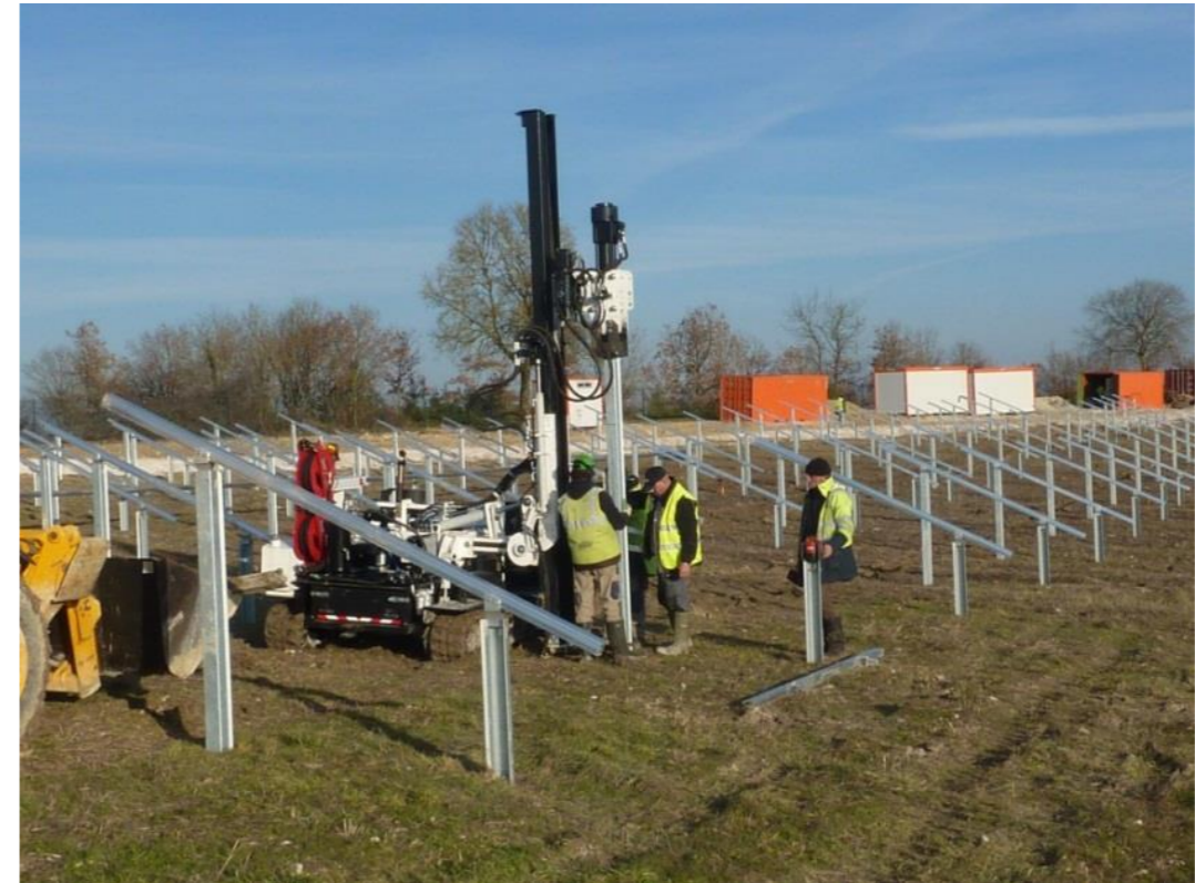
Figure 5 : Mise en place de support de panneaux
