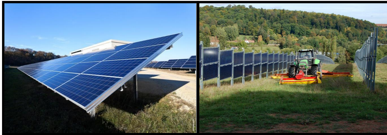
Figure 15 : Photographie d'une table inclinée à gauche et verticale à droite (source : Valeco et Next2Sun)
